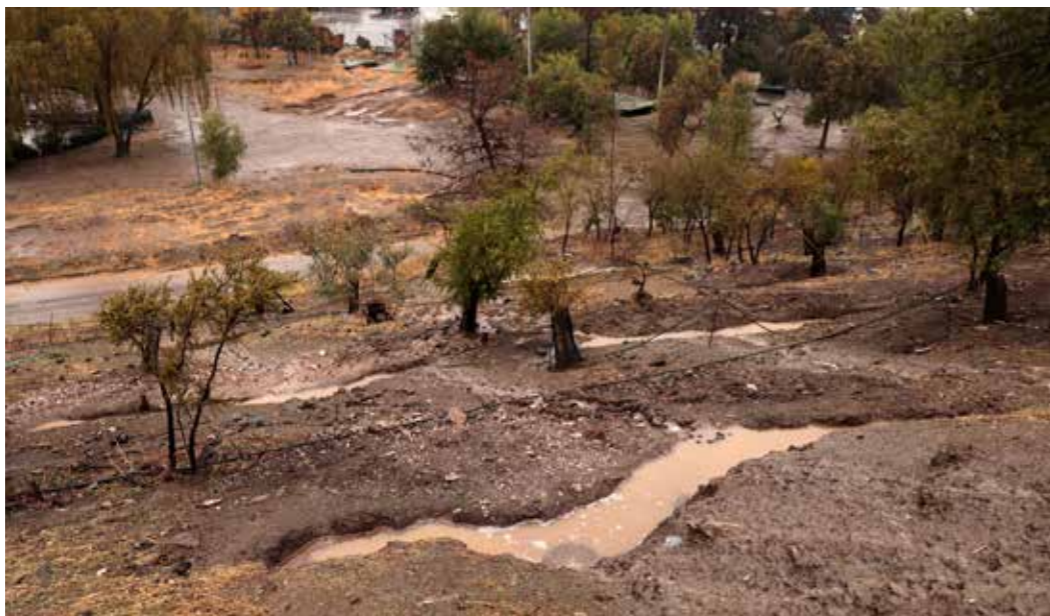
Más de 970 obras para la infiltración de agua lluvia en el Cerro Chena de San Bernardo.
