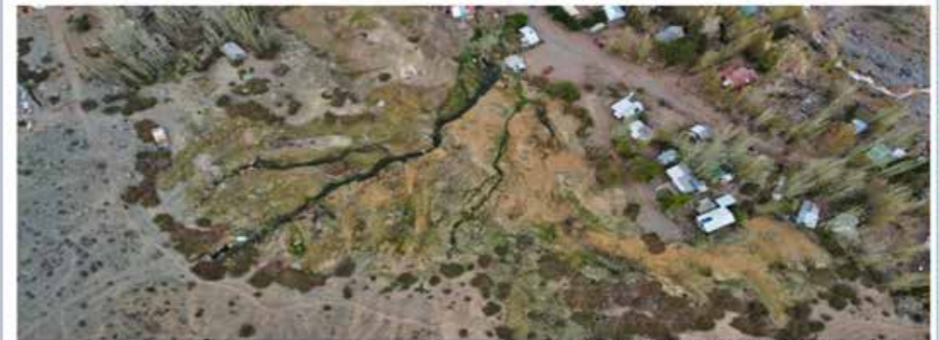
Humedal de Baños Morales (Municipalidad de San José de Maipo)
